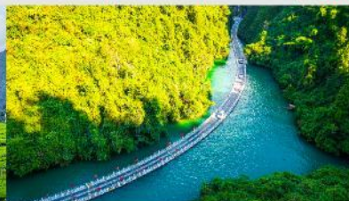
สะพานลอยน้ำสือจื่อกวน
