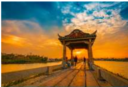
สะพานอันผิง
