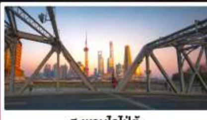
สะพานไวปี้ดู่
